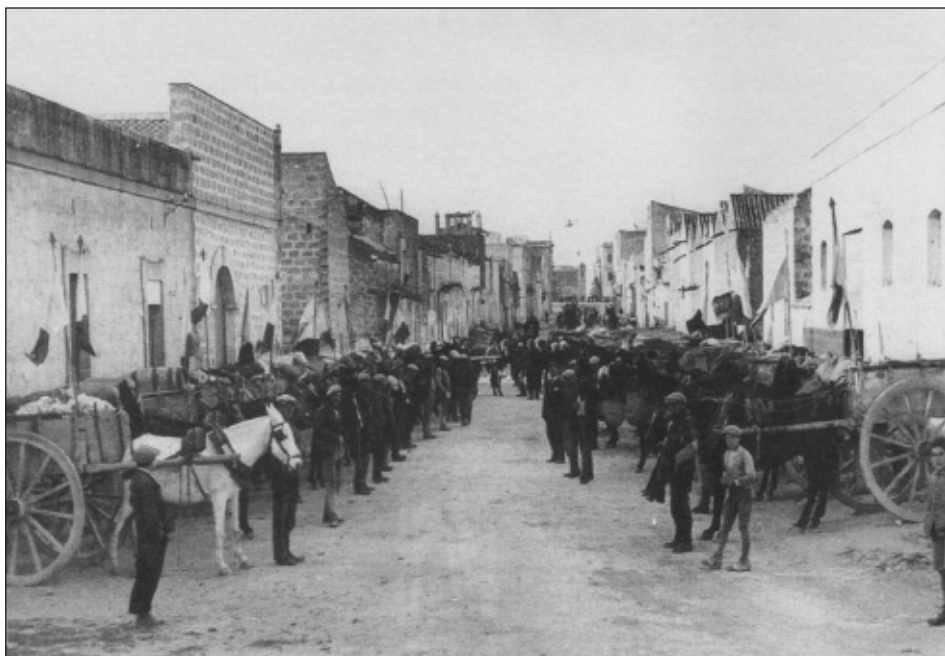
Carretti carichi di pietre schierati in via T. S. Montalto per l'inizio della costruzione dell'edificio della Scuola elementare di Paceco – 1934 (archivio C. Di Bella)
