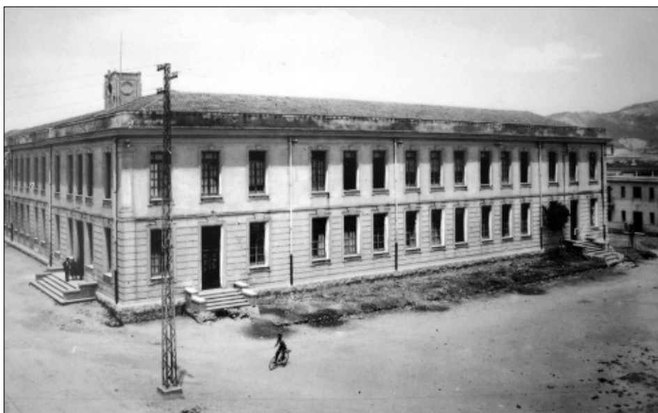
L'edificio della Scuola elementare negli anni '50 (archivio C. Di Bella)
