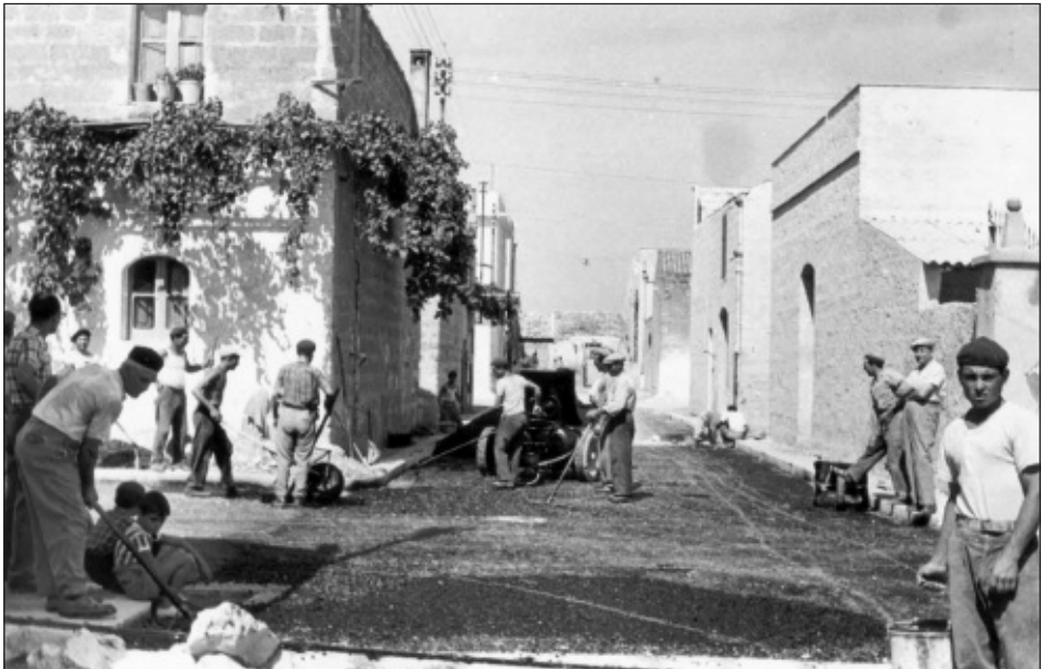
Asfaltatura della via N. Agate all'altezza dell'ex mulino Piazza – primi anni '50 (archivio C. Di Bella)
